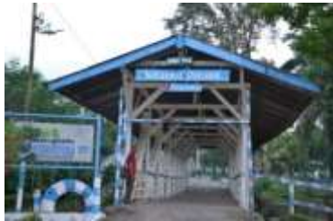
Gambar 4. Jembatan perkebunan yang dibuat tahun 1914 [13]
