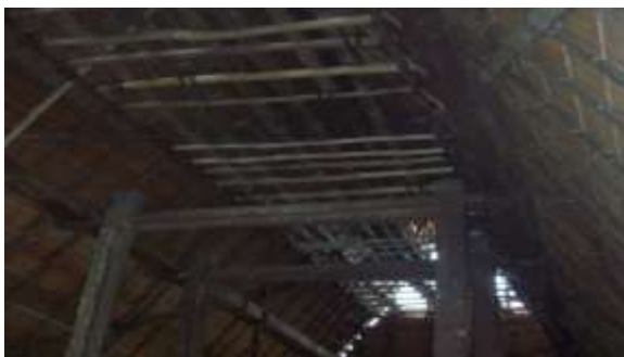
Gambar 6. Bagian dalam Sasadu . Memperlihatkan satu tali Gumutu yang dirajut ke seluruh bagian bangunan.[5].
